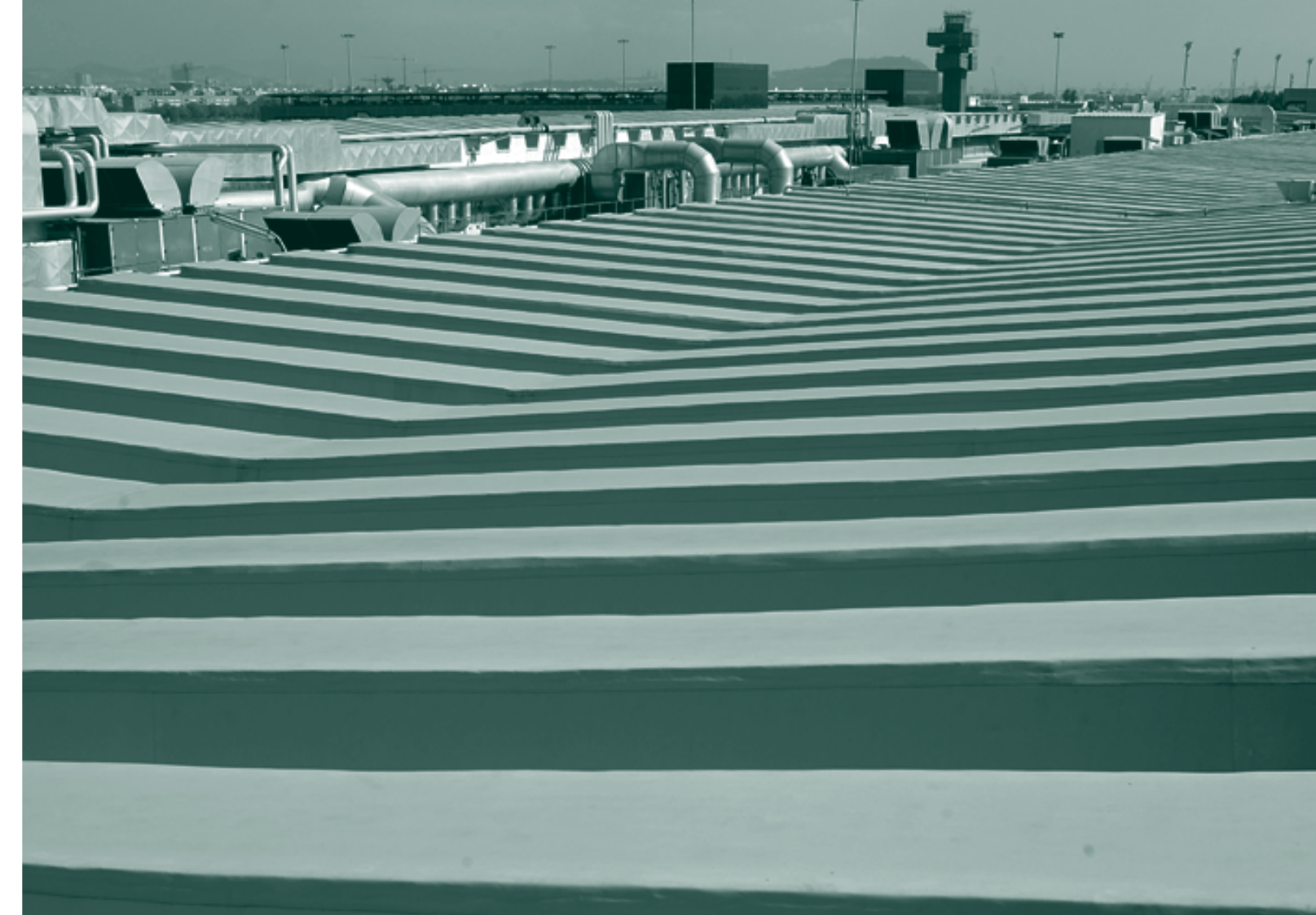
● Aeropuerto Internacional El Prat, Barcelona. VINITEX MP - 42.000 m 2
